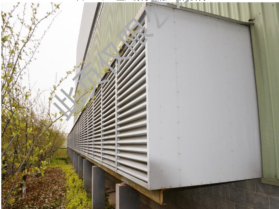
图 7.4-3-2 主厂房进风口消声器实例
