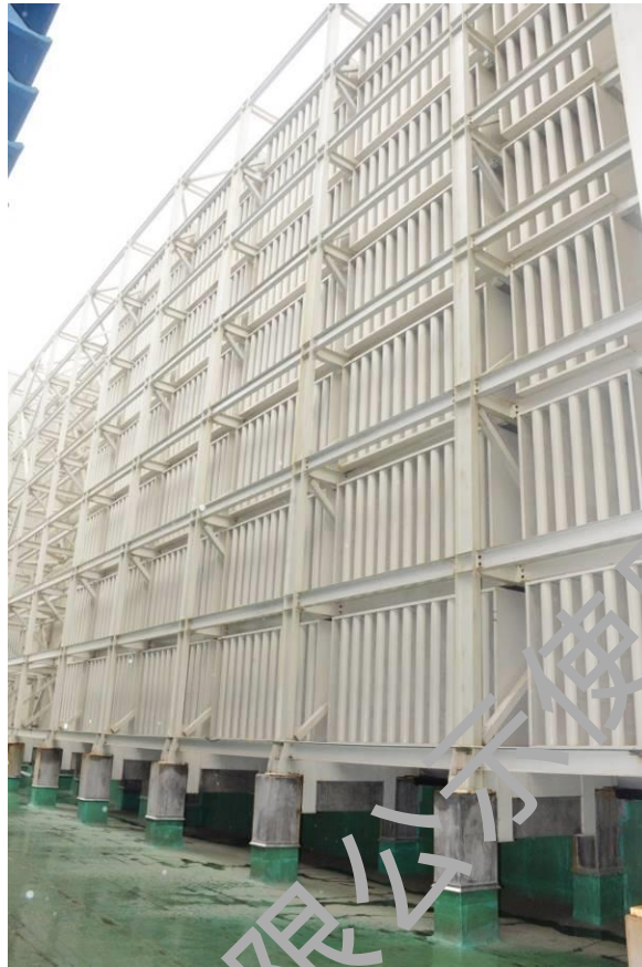
图 7.4-4 进风口消声器实例
