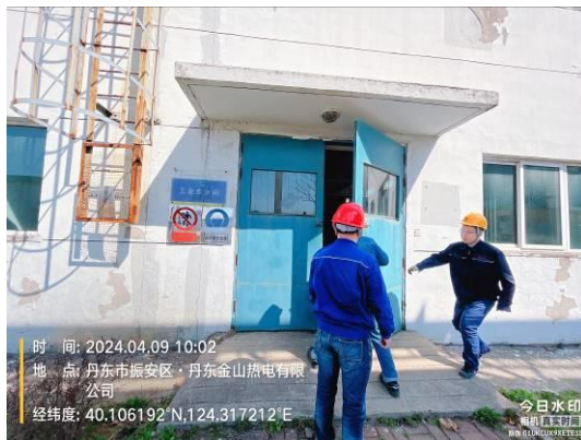
工业废水处理站
