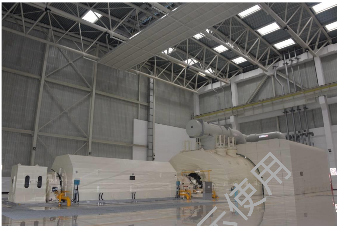
图 7.4-3-1 主厂房内吸隔声墙体实例
