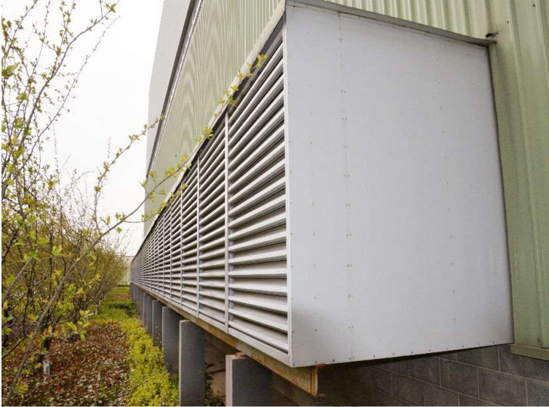
图 7.4-3-2 主厂房进风口消声器实例
