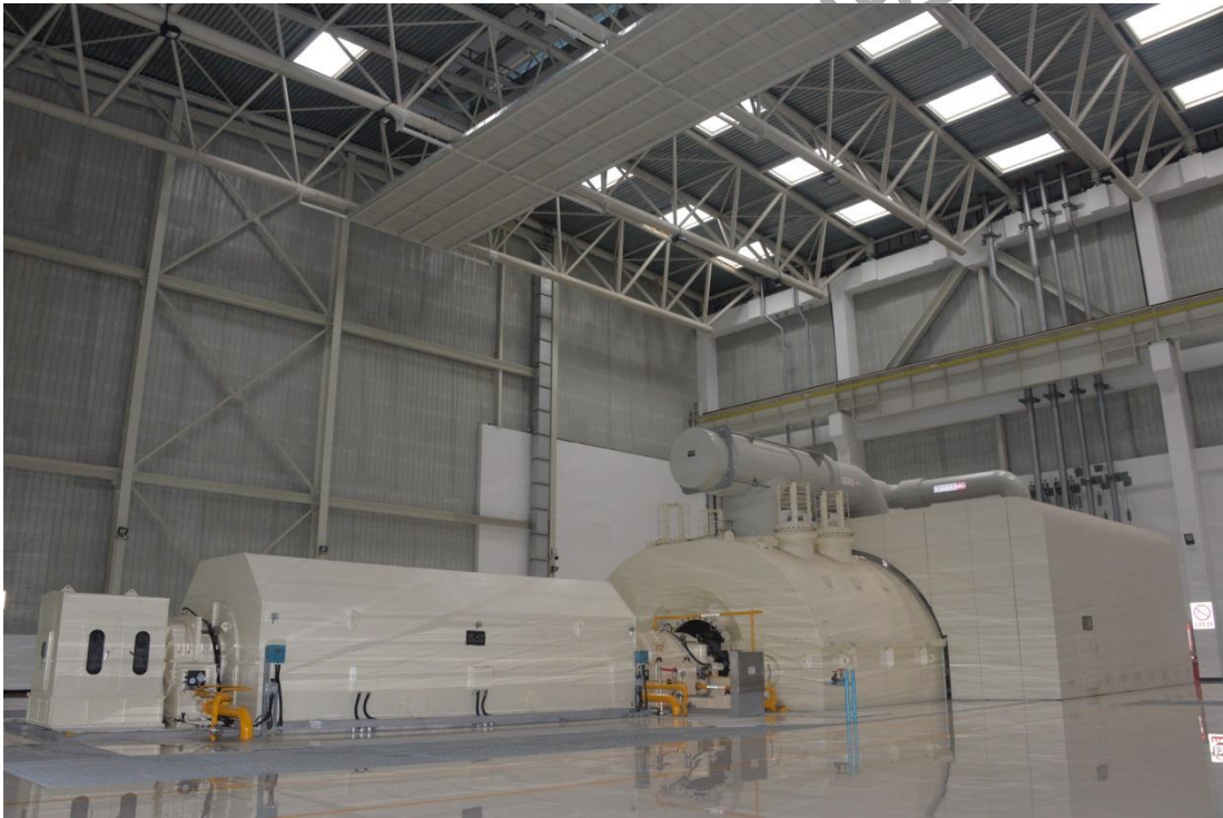
图 7.4-3-1 主厂房内吸隔声墙体实例
