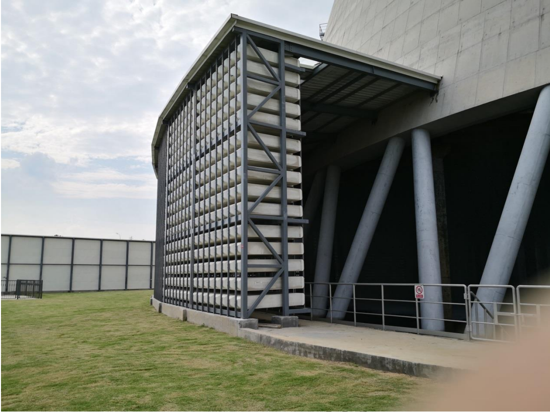
图 7.4-6 冷却塔进风口消声器实例
