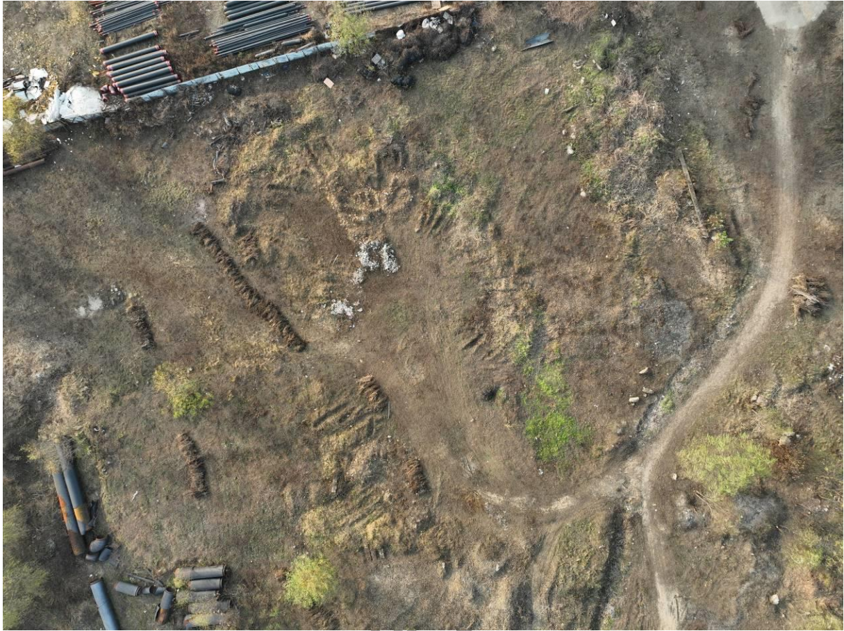
图 5.1-1 厂址现状情况图
