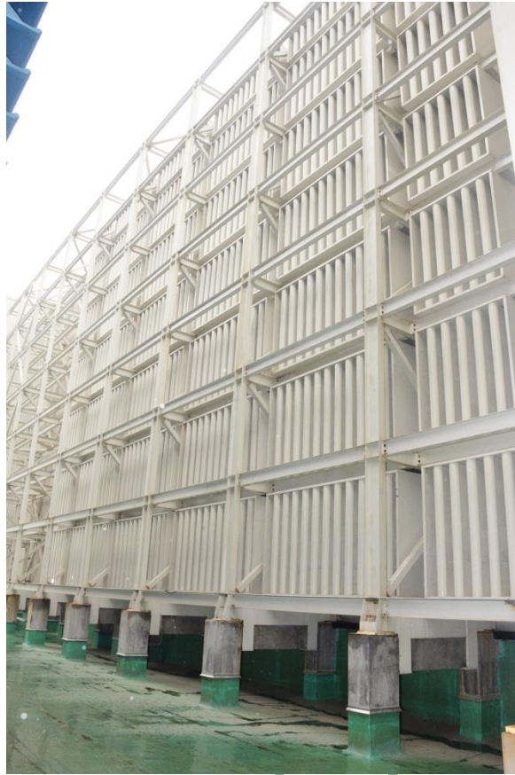
图 7.4-4 进风口消声器实例
