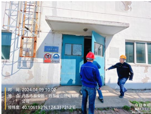
工业废水处理站
