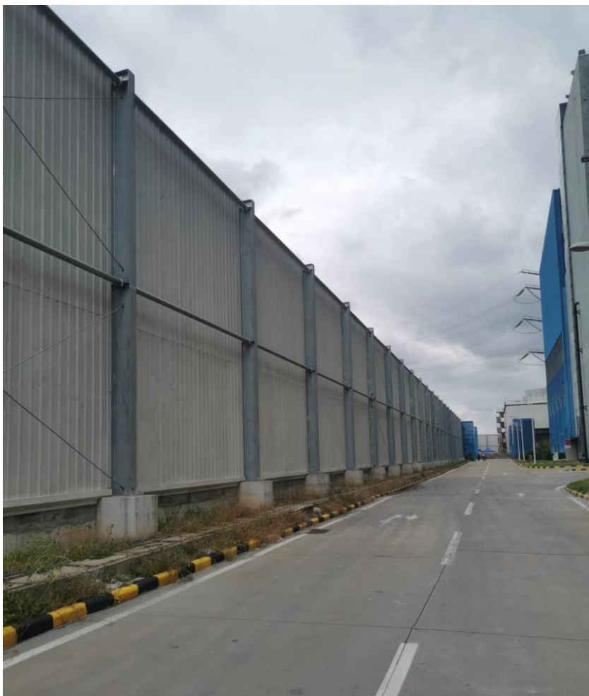
图 7.4-8 厂界屏障实例
